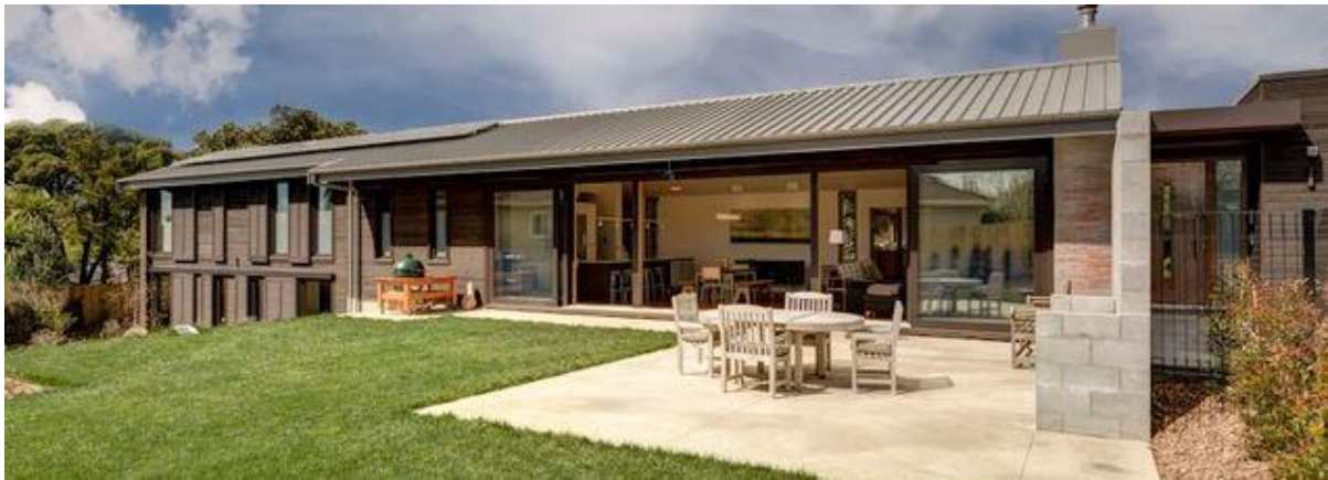
Das erste Passivhaus in Neuseeland wurde 2012 in Auckland im nördlichen Teil des Landes gebaut. Thomas van Raamsdonk war am Bau beteiligt: „Wir haben den Berg als Team gemeistert!“ Foto: PHINZ
